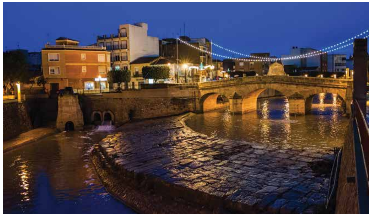
CONJUNTO MUNICIPAL HIDRÁULICO URBANO
